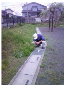
公園側溝フタ 隙間の上
